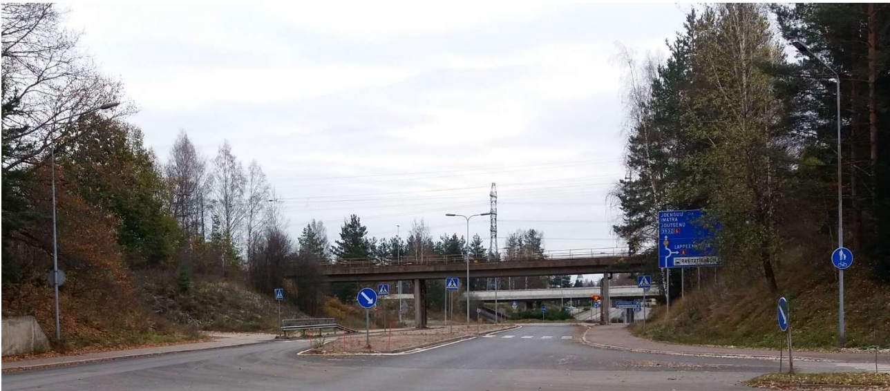
Kuva 5. Saimaantien rautatiesilta pohjoisesta päin syksyllä 2017. Taustalla näkyy valtatie 6:n alikulkusilta.
