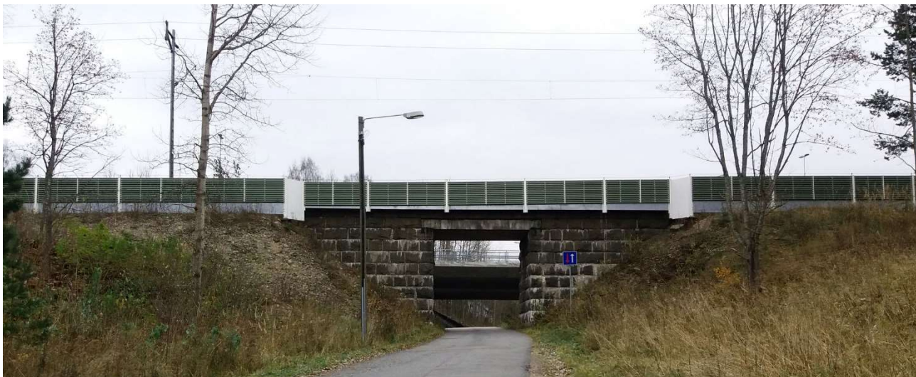
Kuva 6. Kesolantien rautatiesilta pohjoisesta päin syksyllä 2017. Taustalla näkyy valtatie 6:n alikulkusilta.
