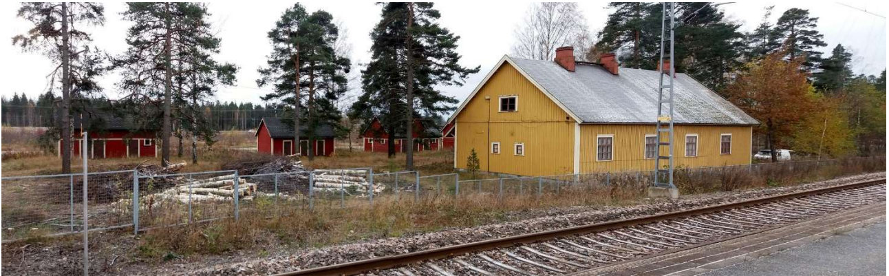
Kuva 16. Joutsenon aseman asuinrakennus ja sen pihapiiriä syksyllä 2017.
