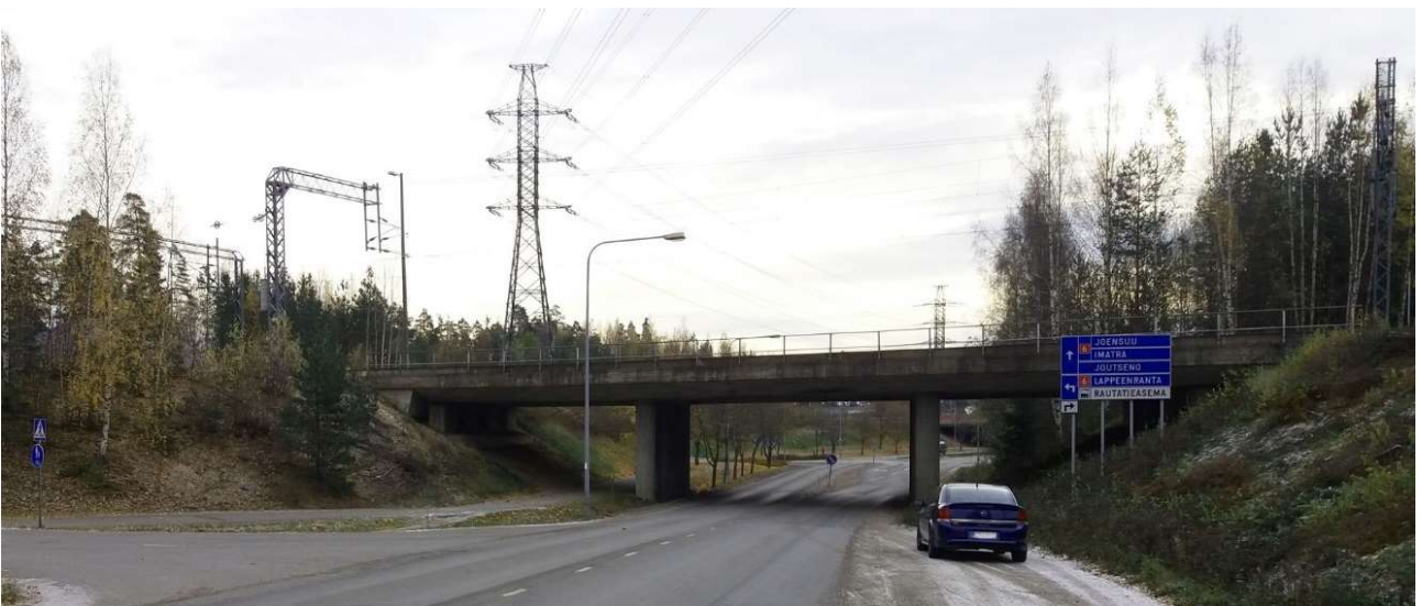
Kuva 4. Teollisuustien rautatiesilta pohjoisesta päin syksyllä 2017.
